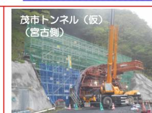
茂市トンネル(仮) (宮古側)では、坑門工のコンクリート打設を行っています。
