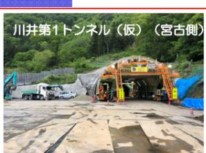
川井第1トンネル(仮)では、覆工コンクリートの施工を行っています。全長1,764mのうち1,110mまでコンクリート打設が進んでいます。
