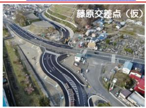
藤原交差点(仮)では、陸間道路との切替えが完了し、路側の排水構造物を施工しています。
