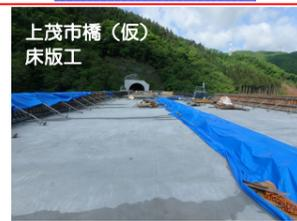
上茂市橋(仮)では、床版工のコンクリート打設を行っています。
