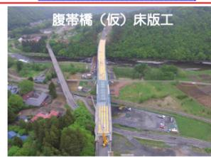
腹帯橋(仮)では、床版を施工するための、型枠組立てを行っています。
