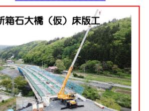
新箱石大橋(仮)では、床版を施工するための、型枠の組立てを行っています。
