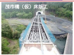
茂市橋(仮)では、床版を施工するための、型枠組立てを行っています。
