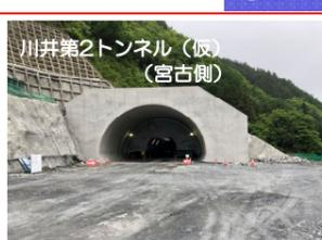
川井第2トンネル(仮)では、覆工コンクリートの施工を行っています。全長1,782mのうち1,378mまでコンクリート打設が進んでいます。
