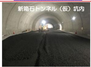
新箱石トンネル(仮)では、コンクリート舗装の施工を行っています。
