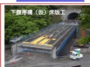
下腹帯橋(仮)では、床版を施工するための、型枠の組立てを行っています。
