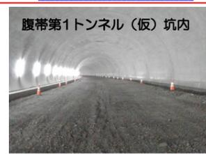
腹帯第1トンネル(仮)では、円形側溝の施工を行っています。
