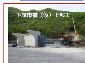
下茂市橋(仮)上部工では、橋桁の架設を行っています。
